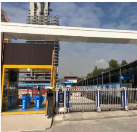
【摩天集团】 前海华强金融大厦项目
